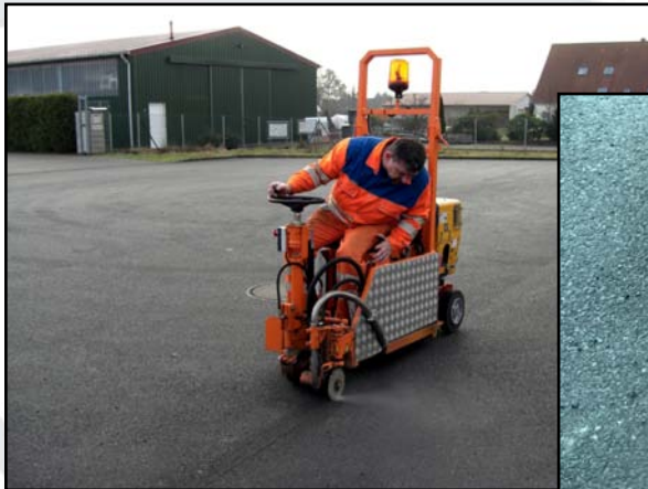
(optional) Erweitern des Risses mittels Rissfräse
