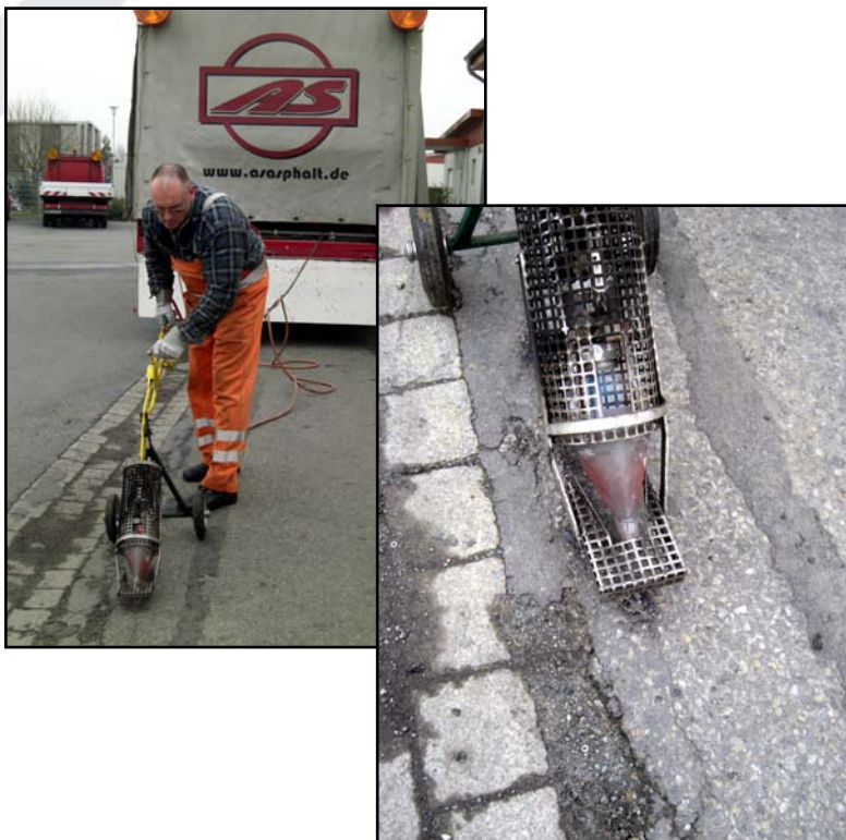
Reinigen des Risses und anschmelzen der Fugenflanken mittels Heißluftlanzenbrenner
