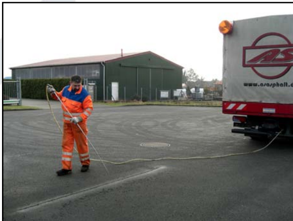
Evtl. Verunreinigungen werden mittels Hochdrucklanze entfernt
