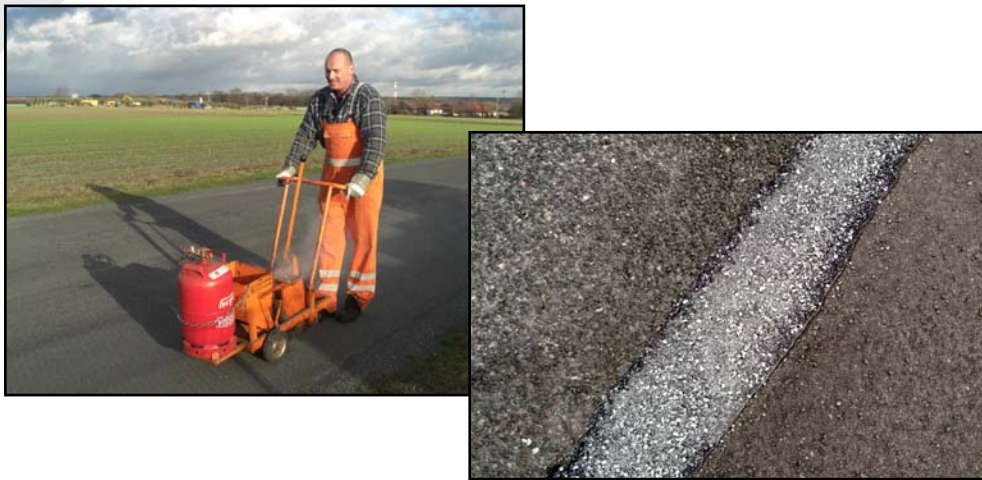
Abstreuen des sanierten Risses mit grober Gesteinskörnung 1/3 mm
