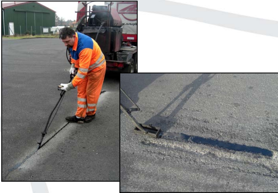
Aufbringen der polymervergüteten Vergussmasse gemäß TL Fug-StB 01
